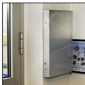
Ankerboks med elektronik DIM: B350xH545xD70
